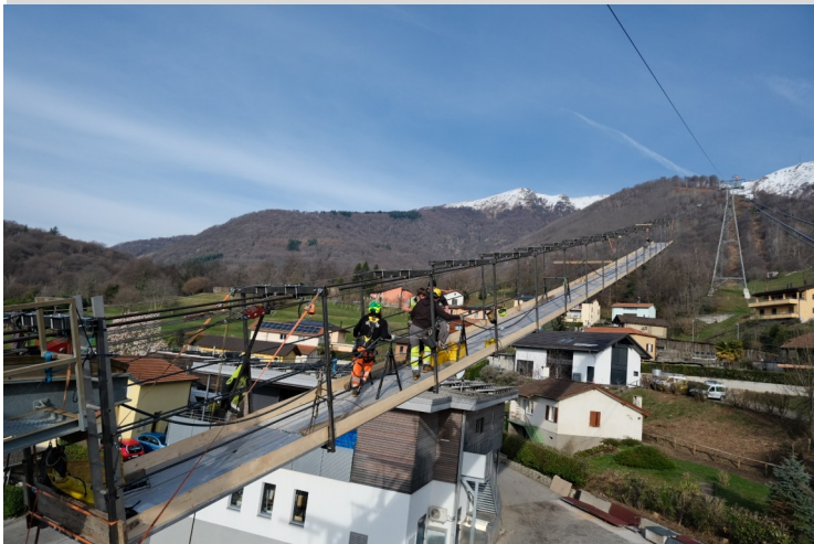
Montage vom Splessgerüst im Tessin
