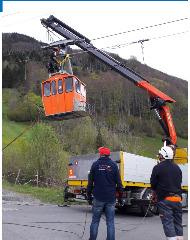
Demontage von Laufwerk, Hänger und Kabine
