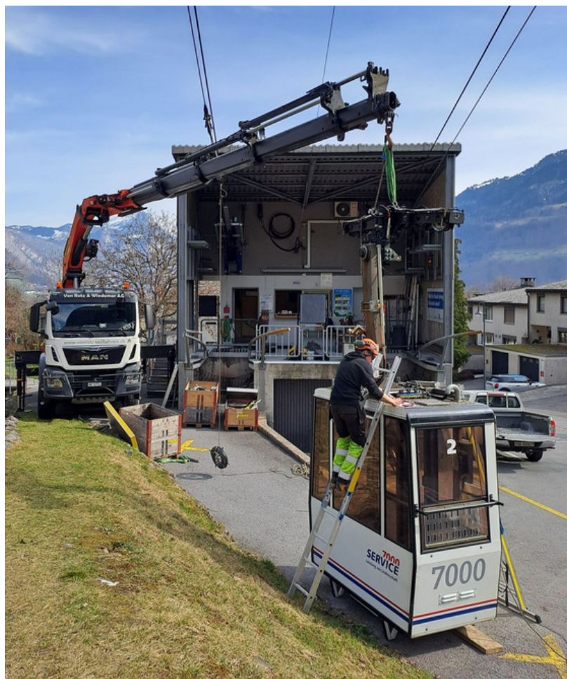
Démontage pour travaux de révision
