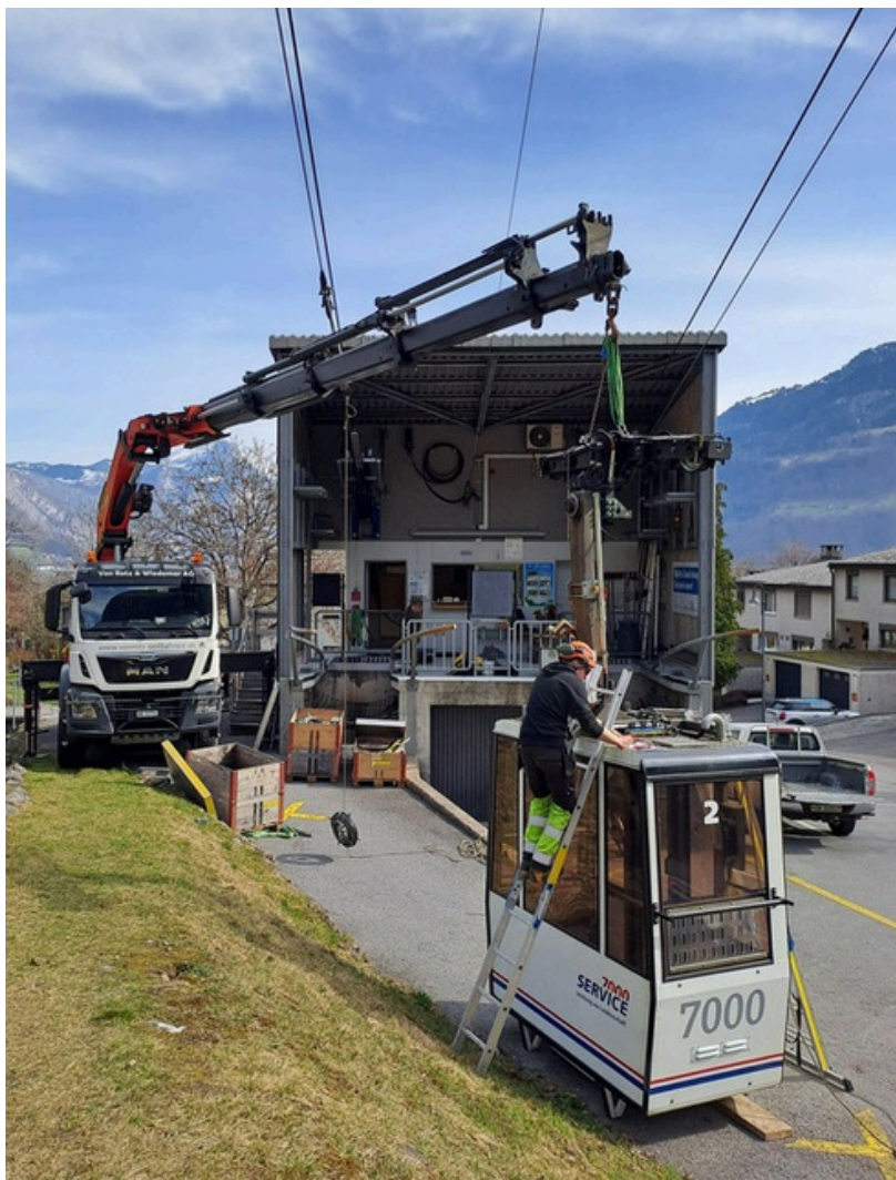
Demontage für Revisionsarbeiten
