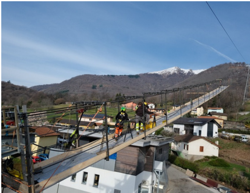
Zugseil kürzen, Montage Spleissgerüst
