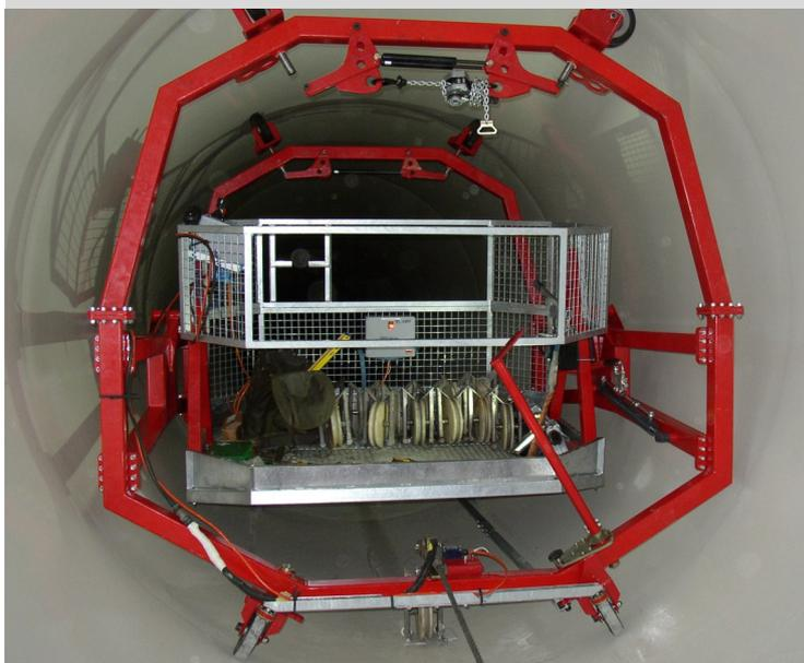
Construction d'un nouveau chariot de puits pour l'accès à un puits incliné et vertical de l'installation Cleuson-Dixence dans le Valais. La plateforme est inclinable hydrauliquement et équipée d'un dispositif de direction. Le puits vertical mesure environ 70 mètres de long.
