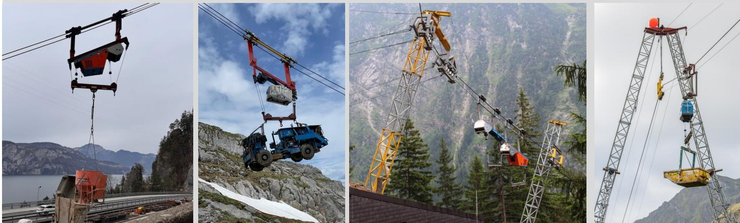
Nous disposons de 4 treuils de location qui sont homologués pour le transport de personnes. Nous disposons également de tout le matériel tel que véhicules et galets de guidage pour permettre le déplacement, que ce soit dans les puits blindé brut ou fini. Nous pouvons offrir tous les systèmes, du treuil de puits avec véhicule, en passant par les véhicules de galerie automoteurs, jusqu'au funiculaire de puits.
