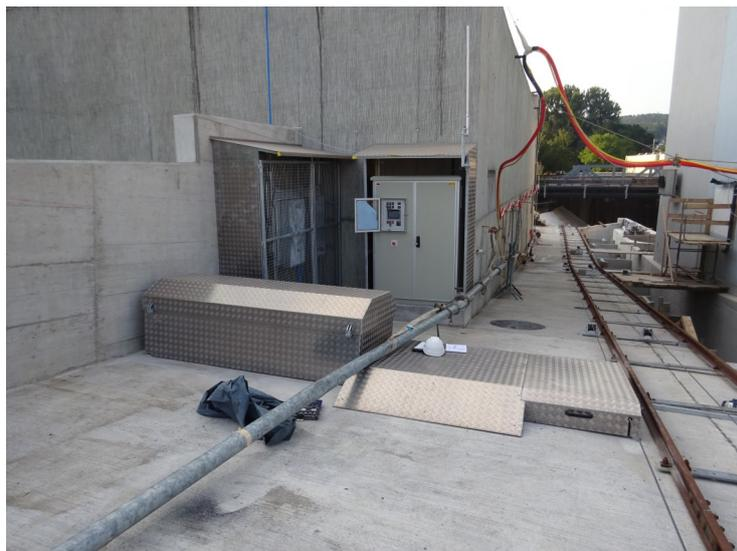
Il contrappeso, l'armadio di comando e il sistema di trazione sono rivestiti da una lamiera in alluminio.
