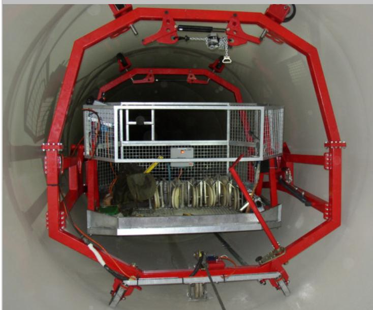
Nuova costruzione di un carro per pozzi per l'inserimento in un pozzo inclinato e verticale dello stabilimento di Cleuson - Dixence, nel Vallese. La piattaforma è inclinabile idraulicamente e dotata di un dispositivo di guida. Il pozzo verticale ha una lunghezza di circa 70 metri.
