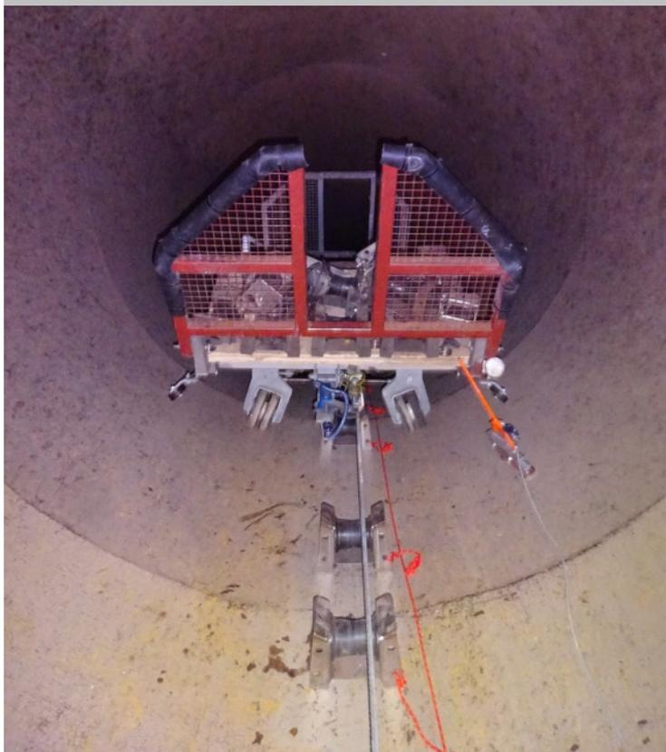
Nebst dem Schachtwagen wurden auch Streckenrollen zum Schutz von Seil und Druckleitung verlegt.
