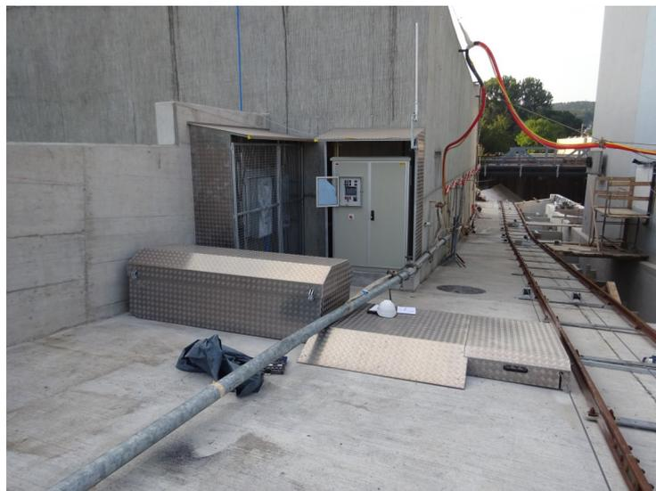
Le poids de tension, l'armoire de commande et l'entraînement sont revêtus d'une plaque chauffante en aluminium.
