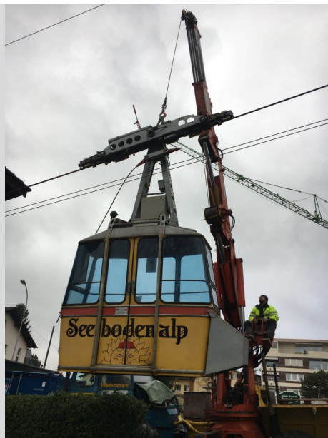
Demontage Kabine mit Gehänge und Laufwerk der LSB Seebodenalp
