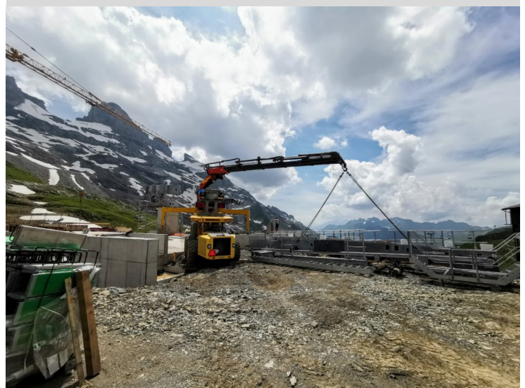
Das Geländefahrzeug „Castor&Pollux“ mit Effer 850 Kran im Einsatz bei der Demontage und Montage der Talstation
