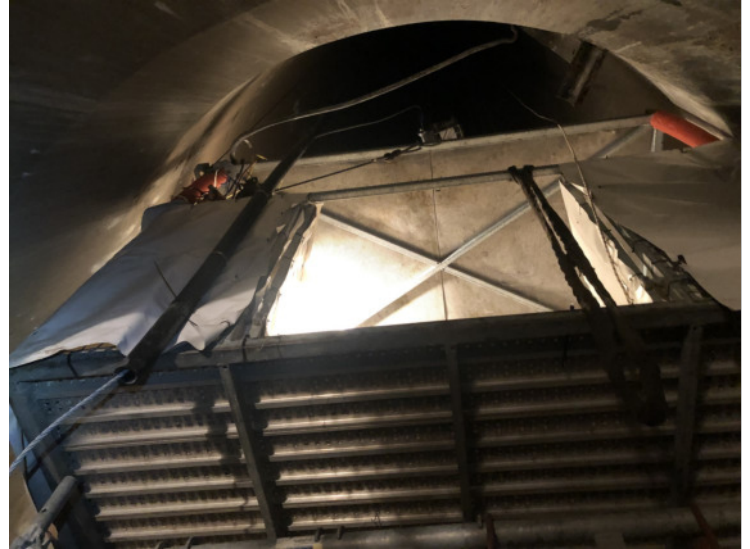
Korb einer ca. 82 Meter langen Vertikalbefahrung
