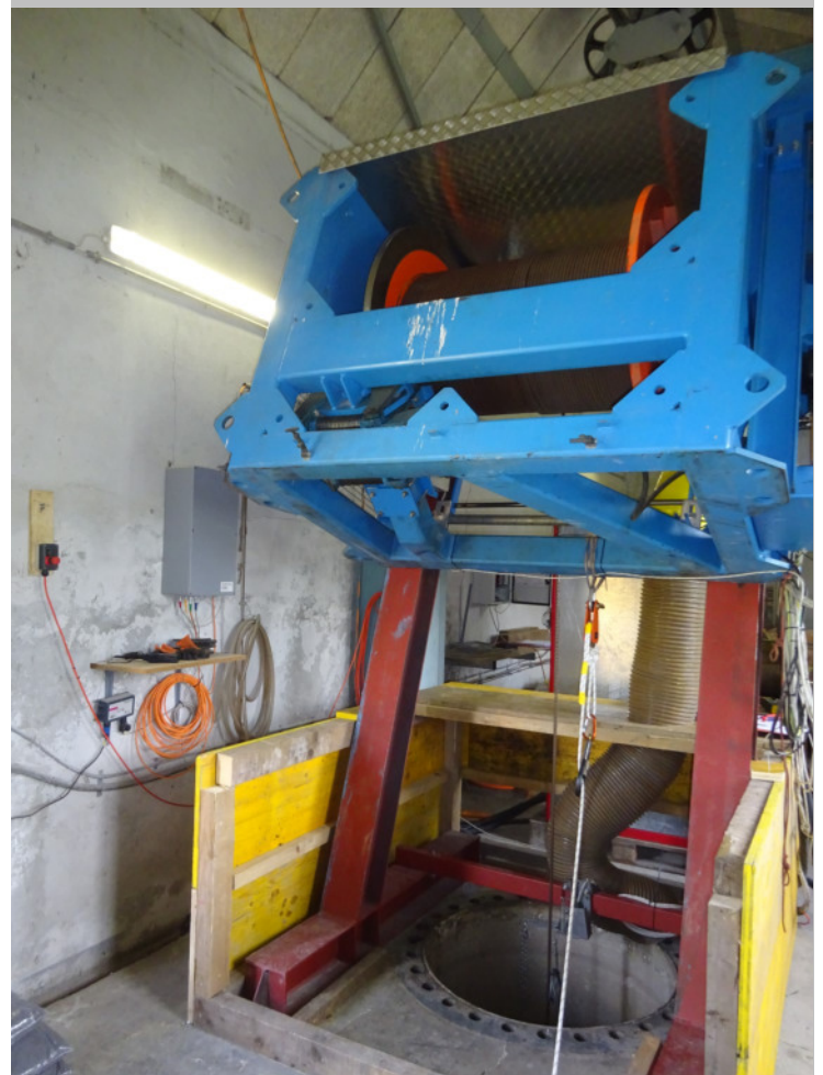
Eine ca. 160 Meter lange Vertikalbefahrung in der Nähe von Nendaz VS.
